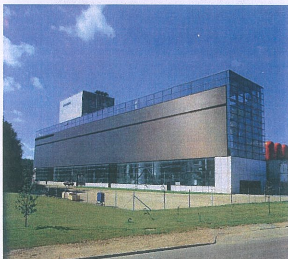
Waste-to-energy plant in Hørsholm, Denmark Client: I/S Nordforbrænding Architect: CUBO Arkitekter A/S
